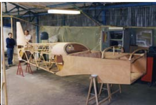
Vue de la structure du fuselage (Ph. JM Pihier)
