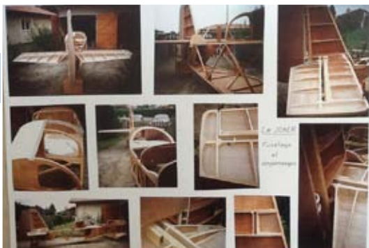
Les liasses de Louis Peña comprennent des photos de construction à toutes les étapes de la réalisation.
