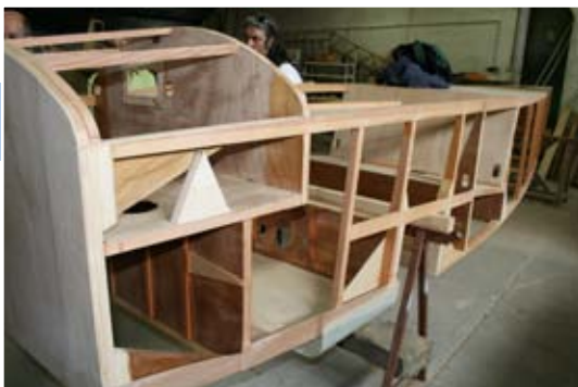
Structure du fuselage avant coffrage. (photo PC)
