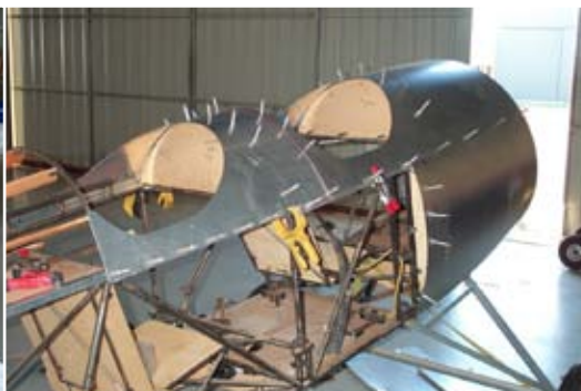
Panneaux en aluminium de la partie avant du fuselage (photo Martin Hone, Rotec)
